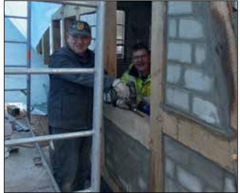
Josef Schenk und Ludger Stevens mauern das Fachwerk aus.
