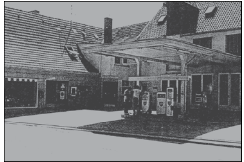
Die Kopie des Fotos zeigt die Tankstelle Nollmann zu BP-Zeiten.
